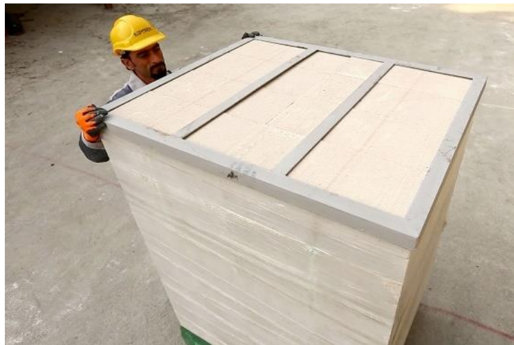
شکل (۱-۳) حمل پالت‌های انتقال بلوک‌های AAC
