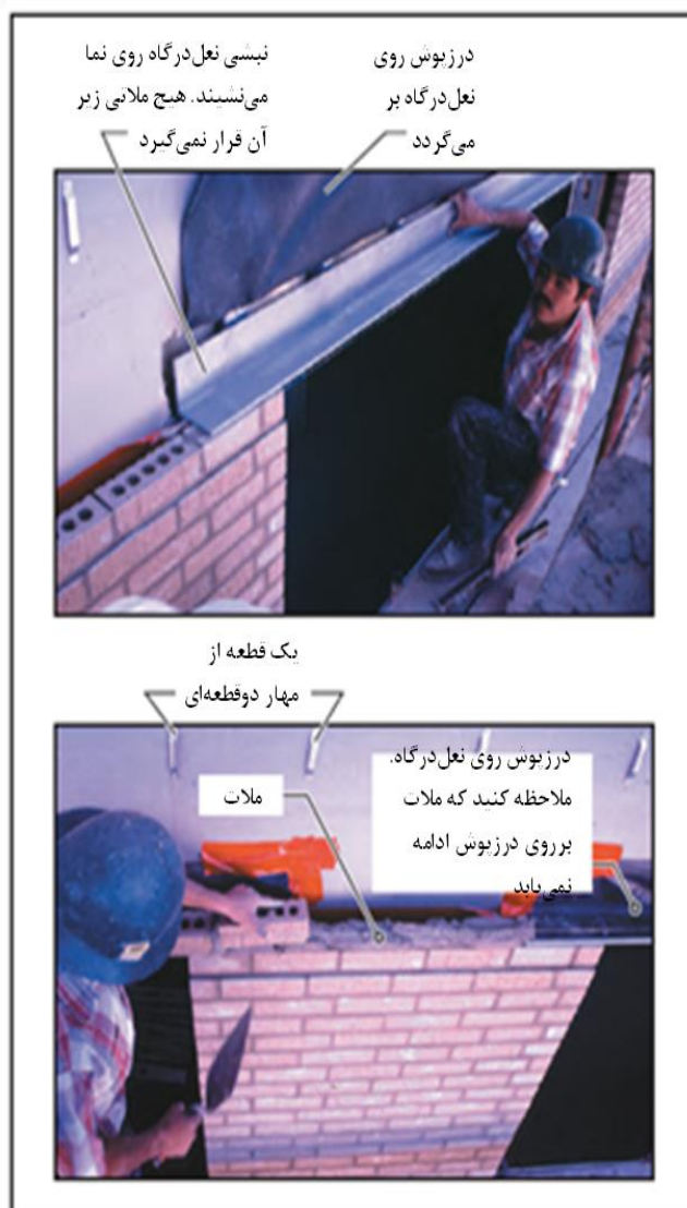
شکل ۵-۱۲ قرار گیری تیر نعل درگاهی در نمای آجری
